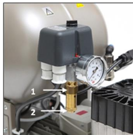
Obr. 7: Kontrola poistného ventilu
