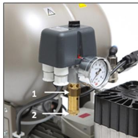
Рис. 7: Проверка предохранительного клапана
