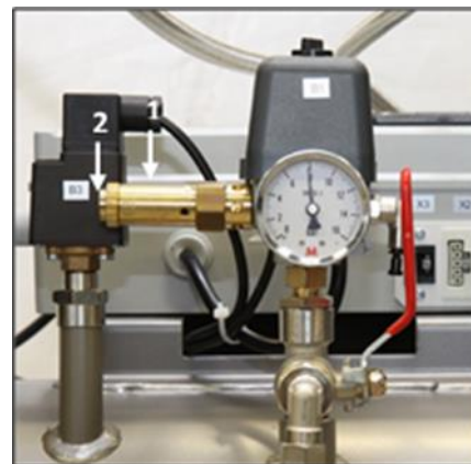
Obr. 25: Kontrola poistného ventilu
