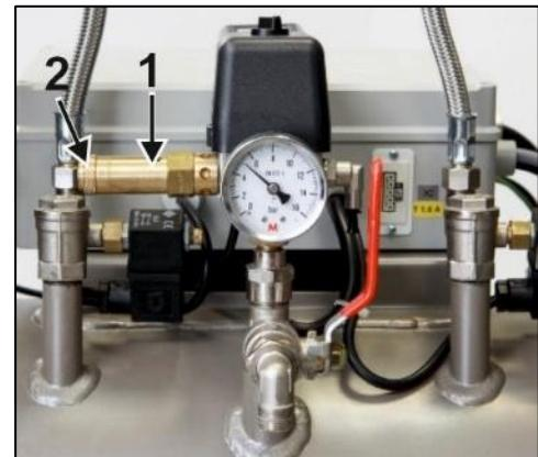
Abb. 24: Sicherheitsventil überprüfen
