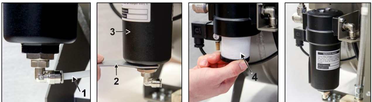
Abb. 18: Austausch des Filterelements
