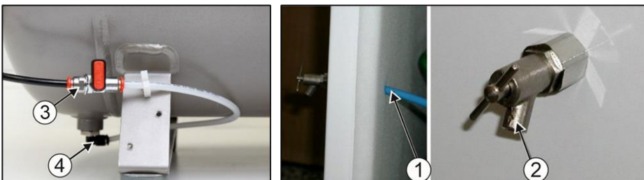
Obr. 7: Osadenie ventilu na odvod kondenzátu na skrinku
