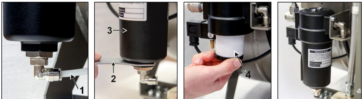
Abb. 18: Austausch des Filterelements
