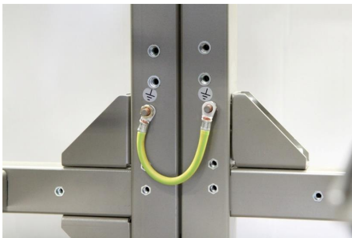
Obr. 8: Ochranné prepojenie rámov
