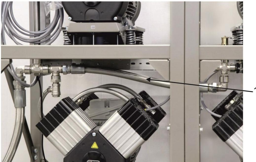
Obr. 12: Prepojenie modulov kompresora
