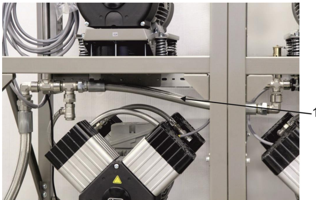
Рис. 12: Подключение модулей компрессора
