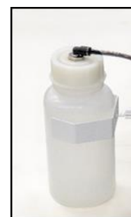
Abb. 11: Überprüfen des Kondensatauffangbehälter
