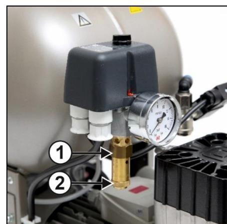
Abb. 13: Sicherheitsventil überprüfen
