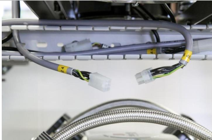
**Obr. 8: Ochranné prepojenie rámov**
