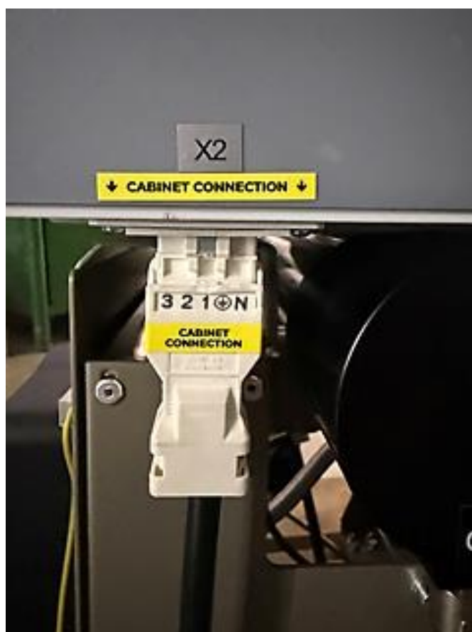
Obr. 11: Zapojenie skrinky ku kompresoru
